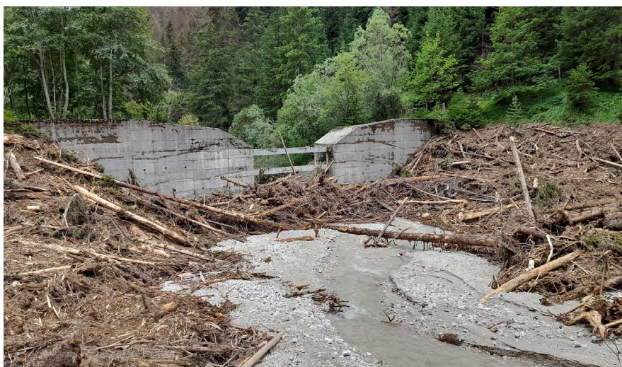
Briglia filtrante e piazza di deposito rio Udai (foto: Servizio Bacini Montani PAT).
