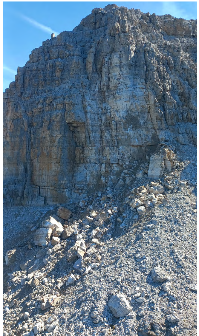
Crollo dovuto al degrado del permafrost, avvenuto in Trentino nell'estate 2023 (foto: Servizio Geologico, PAT).
