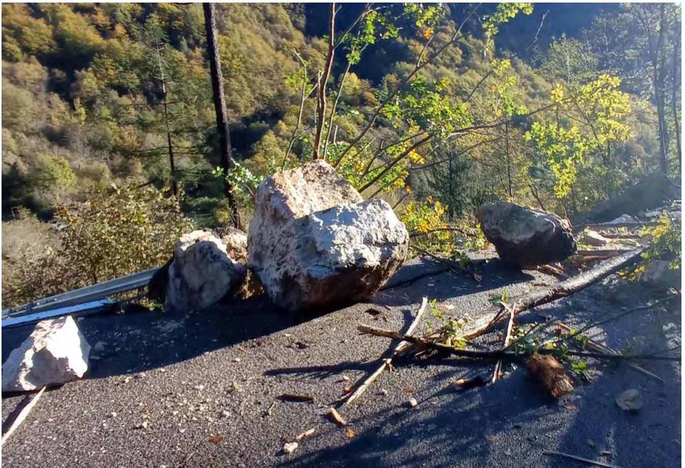
Danni causati da evento di frana sulla SS350 di Folgaria e Valdastico (foto: Servizio Gestione strade PAT).
