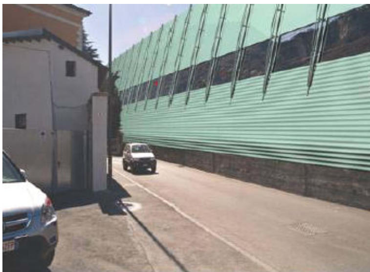
Figura 1 – Barriere con altezza superiore a 7 metri
